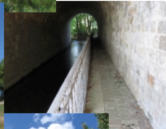
Pont sous voie ferrée
